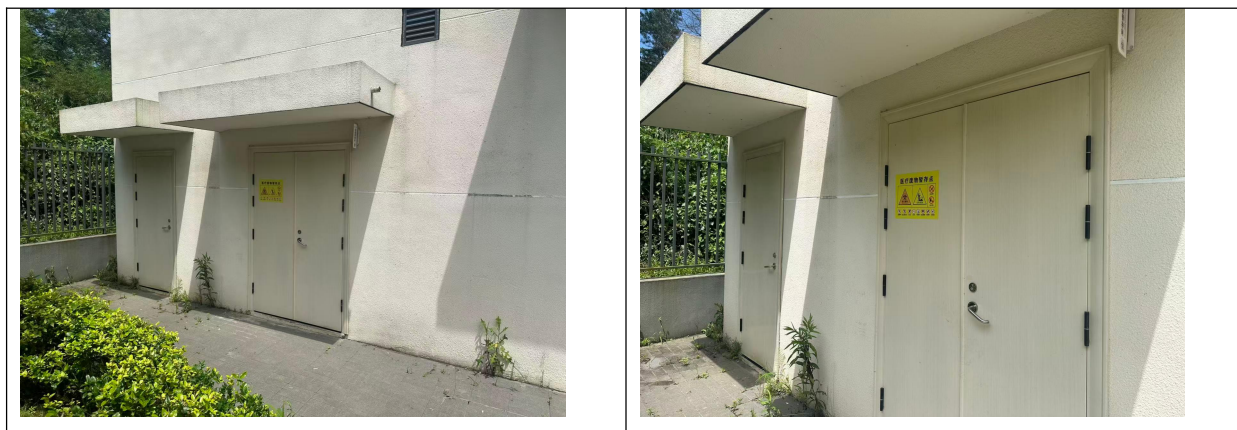
图 4.1-6 危废暂存设施图
