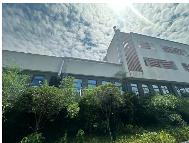
检验废气排气筒
