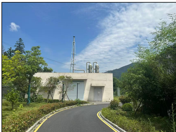
污水处理站环保设施及排气筒
